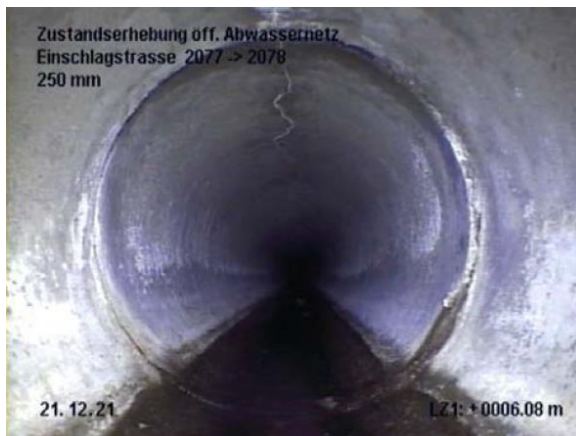
Abbildung 5 und 6: Zustandfotos Kanalisationshaltungen Einschlagstrasse
